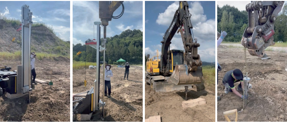
〈생태모방 확공용 굴착 공법을 이용한 매립지 안정화 시공 과정 : 확공 장치 기립, 자리 잡기용 타격, 확공 및 타격, 확공기 회수〉
