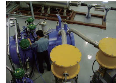
〈초전도 케이블 냉각시스템〉
